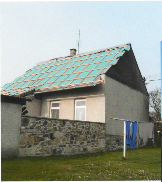
Nová střecha u č.34.
