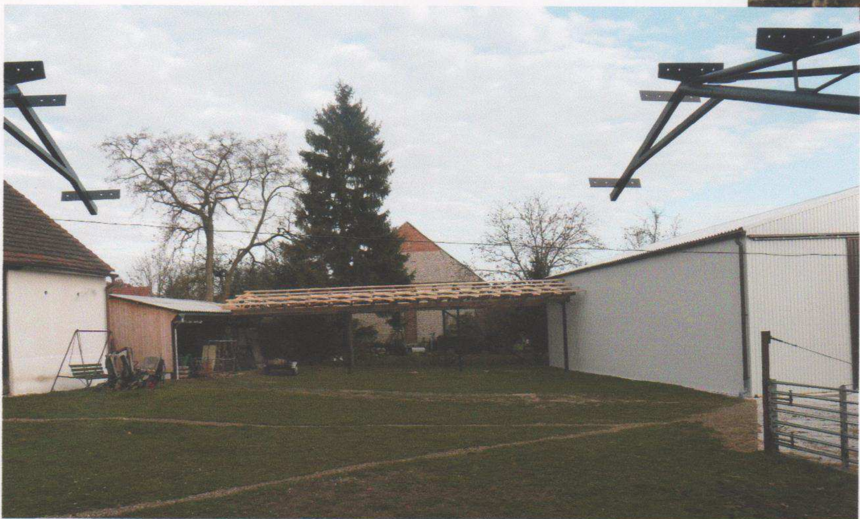
Na zahradě č.6 se budují nové přístřešky na stroje.
